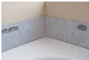
Das Struktur Dichtband
